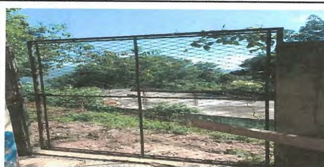
Foto 6: Suministro de instalación de porton de acceso.
