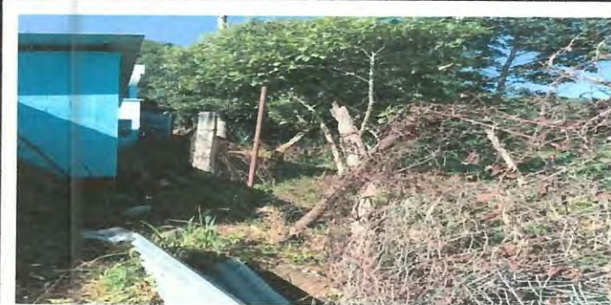
Foto 5: Mejoramiento de muro perimetral con tres hiladas de block, simintación, tubos y malla galvanizada.
