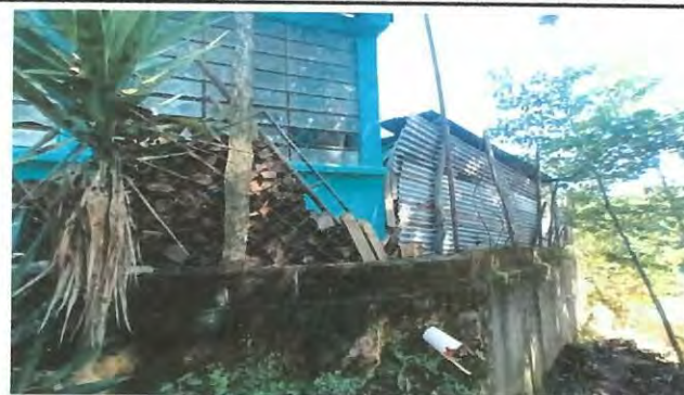
Foto 2: Mejoramiento de muro perimetral con tres hiladas de block, simintación, tubos y malla galvanizada.
