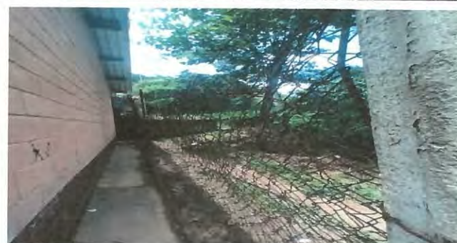
Foto 4: Mejoramiento de muro perimetral con tres hiladas de block, simintación, tubos y malla galvanizada.
