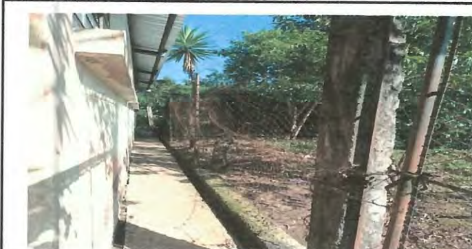
Foto 3: Mejoramiento de muro perimetral con tres hiladas de block, simintación, tubos y malla galvanizada.
