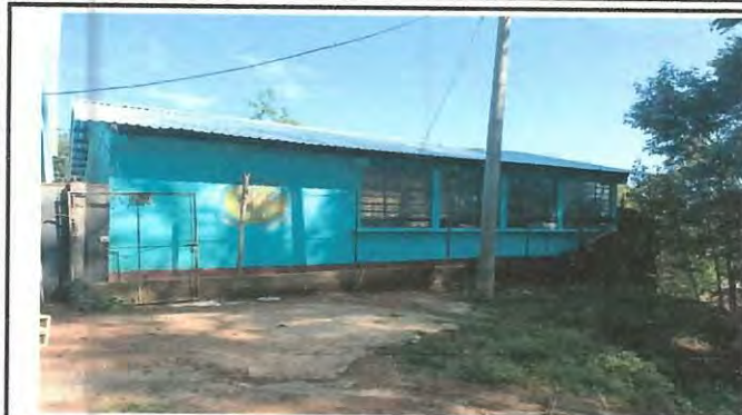
Foto 1: Mejoramiento de muro perimetral con tres hiladas de block, simintación, tubos y malla galvanizada.
